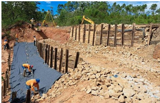
Figura 1. Cravação de estaca metálica na ocorrência de Alfredo Vasconcelos.
